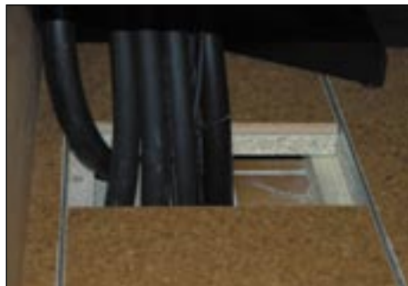
Die Kabelkanäle im Zwischenboden
